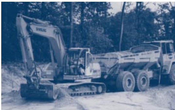
Graafmachine met dumper
