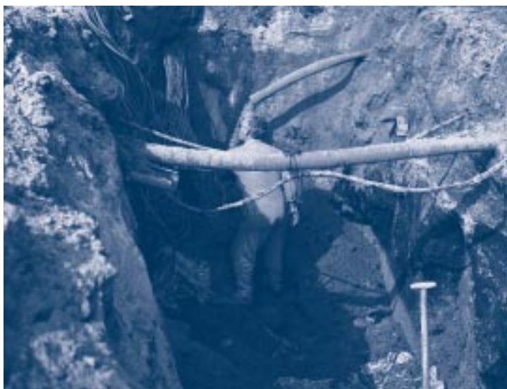
Kabels en leidingen in de grond
